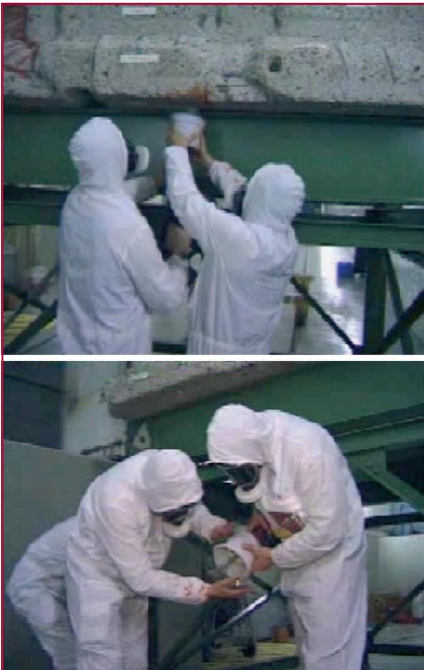
**Fig. 1 - Prélèvement d'échantillons sur des surfaces de béton à l'aide d'une perceuse mécanique banale équipée d'une tête de fraisage, et à l'aide d'un bécet pour recueillir la poudre (haut) ; transfert de la poudre dans un conteneur de mesure (bas) (photos tirées de [KWW 04])**
